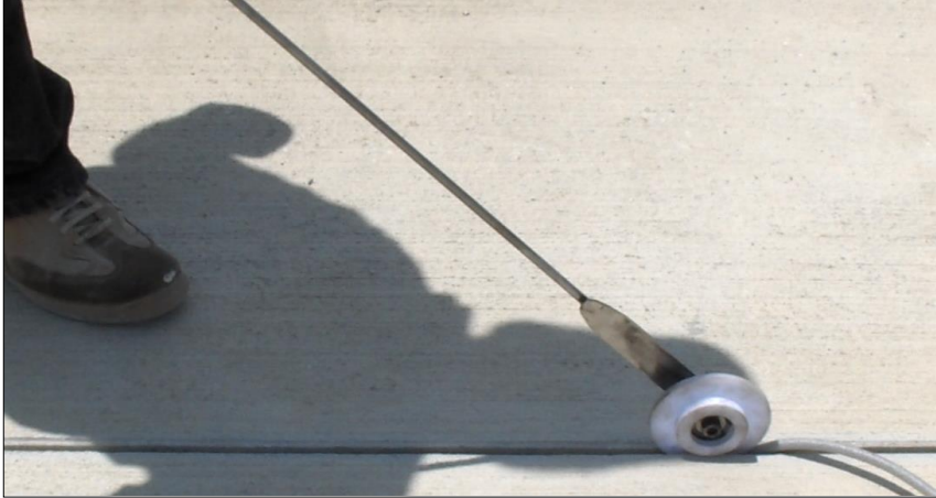
Resim 6. Derz taban fitilinin yerleştirilmesi
