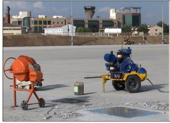
Resim 2. StenCare ® ile onarılmış beton zemin
